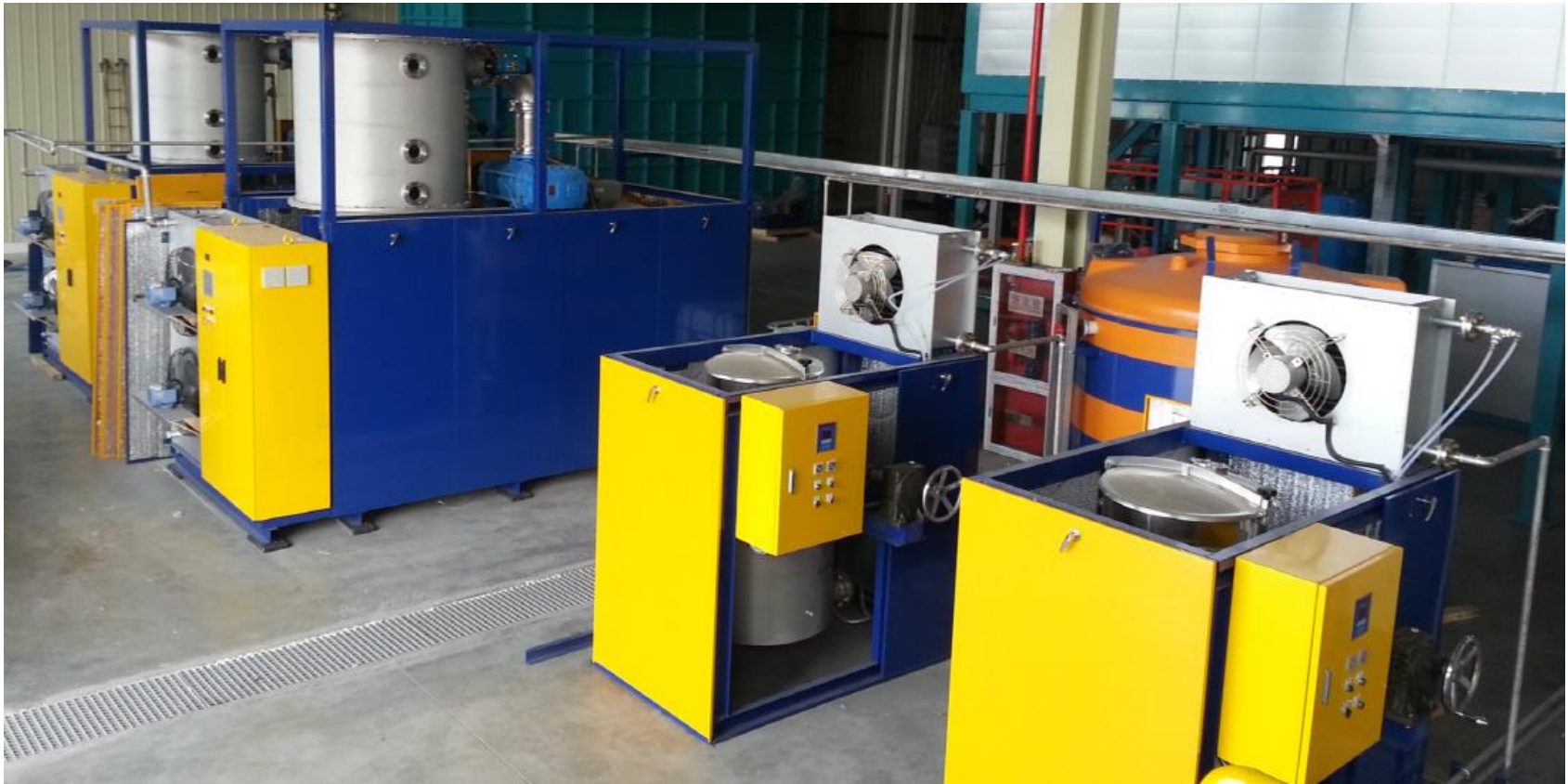
동희산업 중국 염성(염청) 공장 도장공정 무방류 폐수처리 시스템 : 일일 100톤
