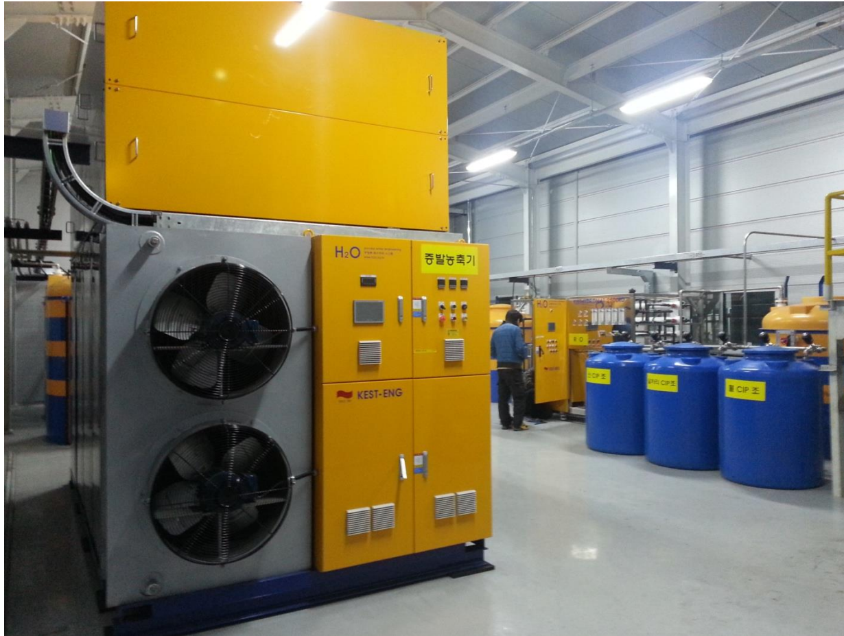
대원강업 도장공정 무방류 폐수처리 시스템 : 일일 50톤
